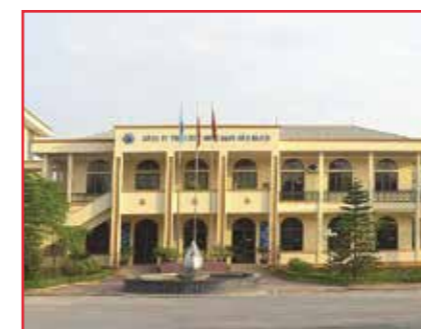
▶ Hệ thống xử lý nước sạch Hà Nội Hanoi water treatment system
